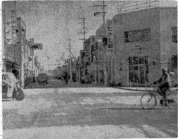
平市公会堂本館(常設市開)の敷設完了。四丁目の舗装も完了した。
