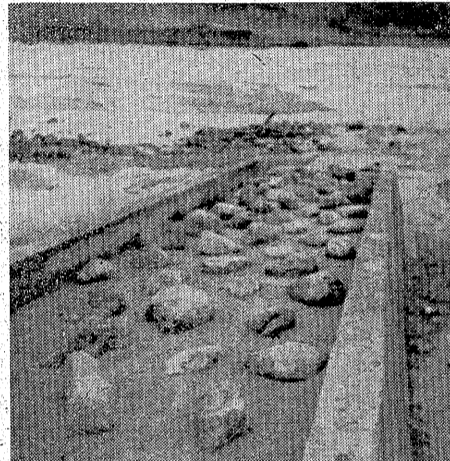
愛谷堰にアユの魚道が完成し、アユの遡上が可能になった。
