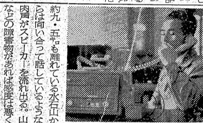
【写真は水石山に無線電話を設備する様子】
