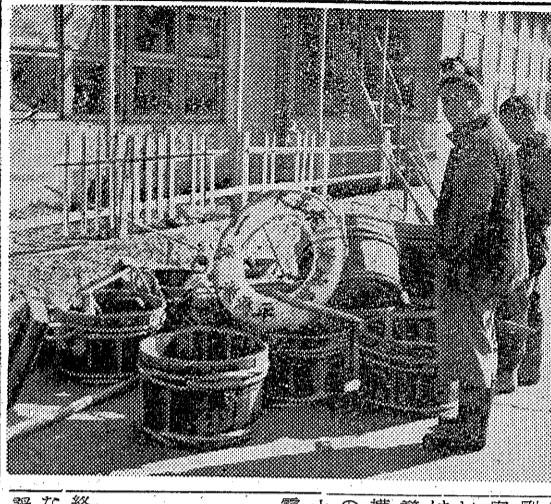
【写真】船内から発見された乗組員の遺品。船は沈没後、防波堤に激突し、船内は壊滅した。乗組員は行方不明となっている。
