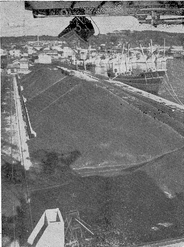
一万トンの西側を埋め立てて拡張 五千重量トンの貨物船二隻が接岸できる
