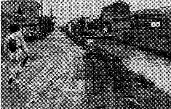
北白土の県道拡張工事現場。
