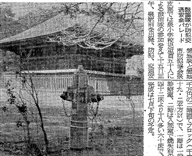
浄土庭園も七月に復元 阿弥陀堂に消火栓
