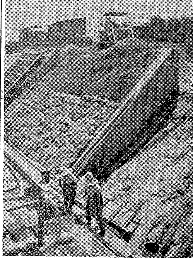
機械化工事進む第三期工事現場
