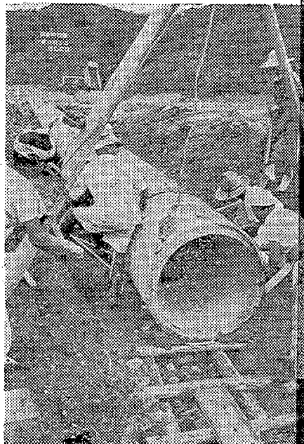
下水を処理する排水管工事 新川に排水する
