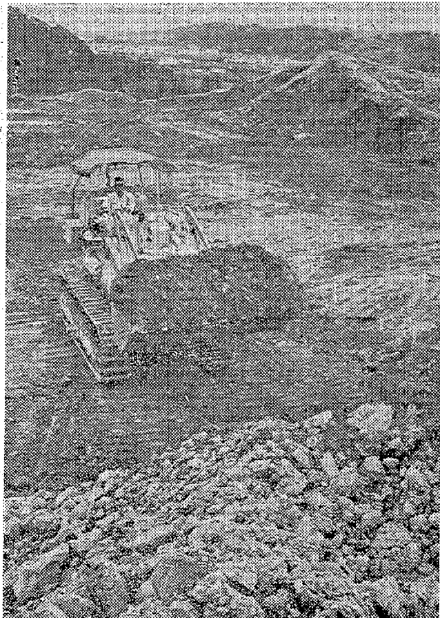
くずされた土を低地に運ぶ巨大なパワーショベル
