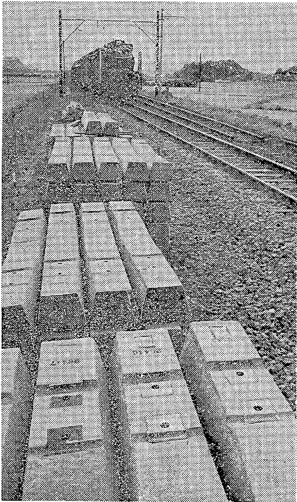
旧軌道の枕木も 全部コンクリート製の枕木となる
