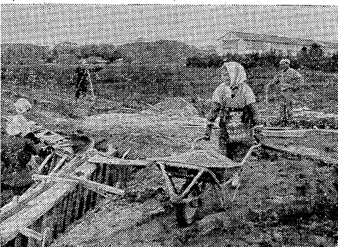
動力機械がしゅうぶん活動できるような幅4・5分の農道拡張工事が進んでいる
