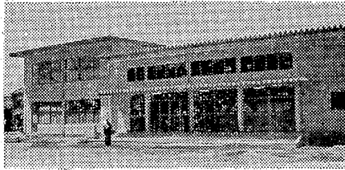
町が誇る新設の久之浜公民館
