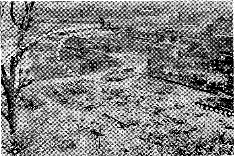
切り削りする谷地から見た新鎌田橋(京線内が取付け道路)
