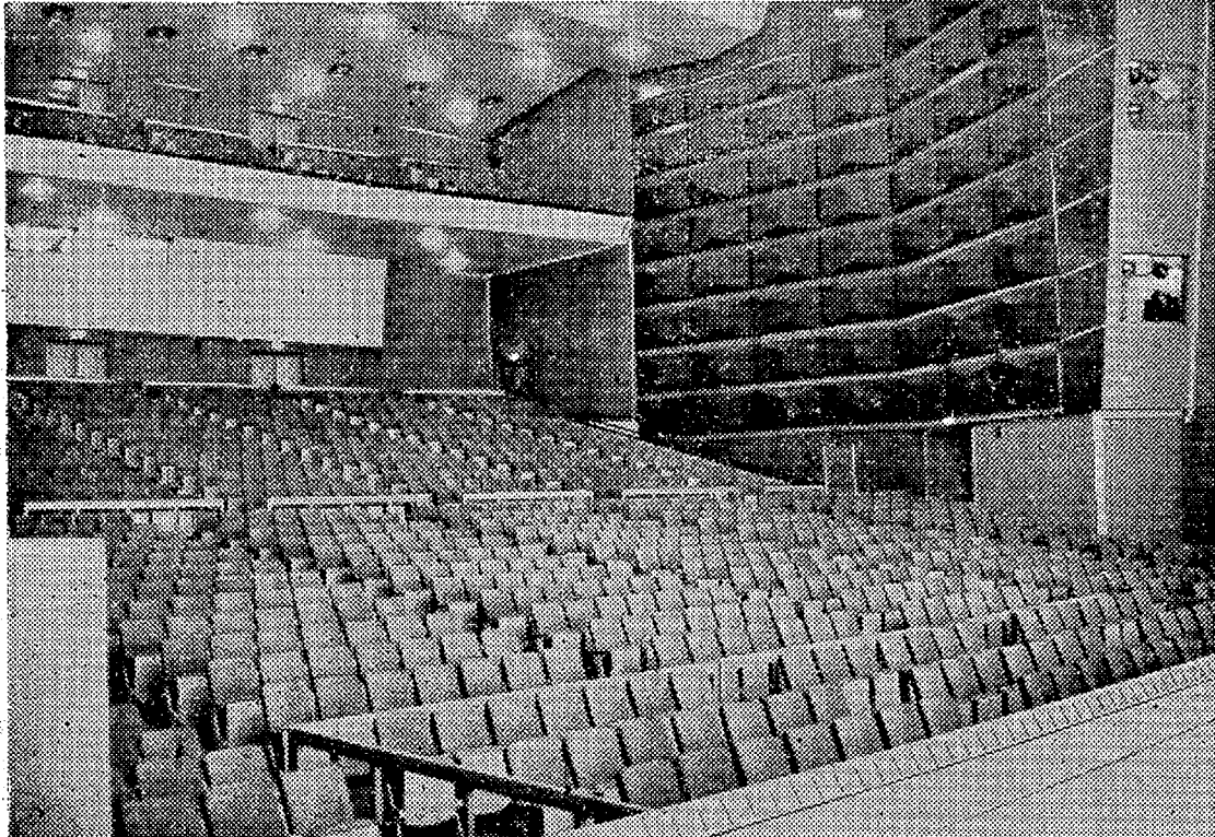
全指定席1800人を収容できるステージ付き大ホールはほぼ完成 照明・音響効果のテストに入っている 右側が音響効果板とスポット用の窓
