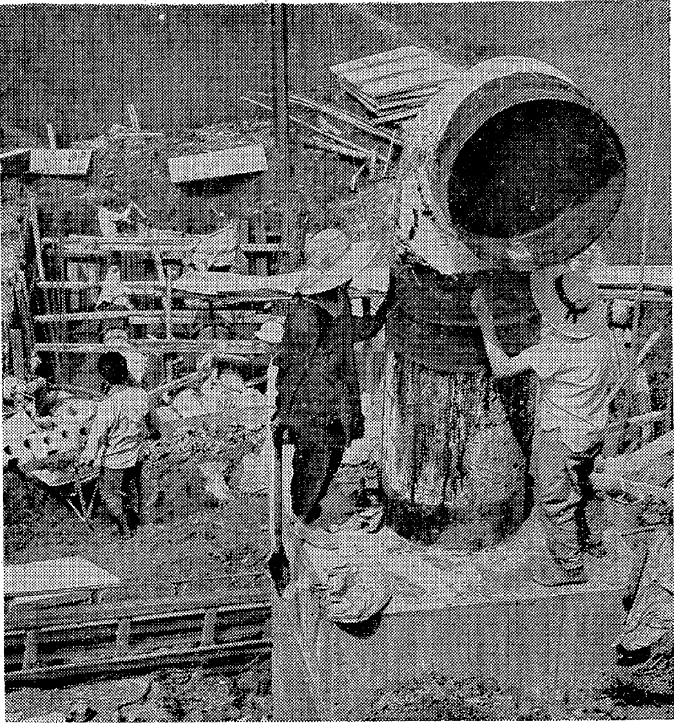
泉浄水場付近の配管工事現場 6百mmの太い鋼管が 新産都市発展の原動力となる 常磐まで4千5百km余を布設する
