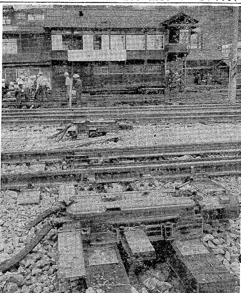
新線への切り替え工事で、平駅構内に列車軌道12、車両運搬区画243、電気ポイント68、信号機103が設置された。前方が電気ポイントと後方の建て物が廃止された手動扱い所
