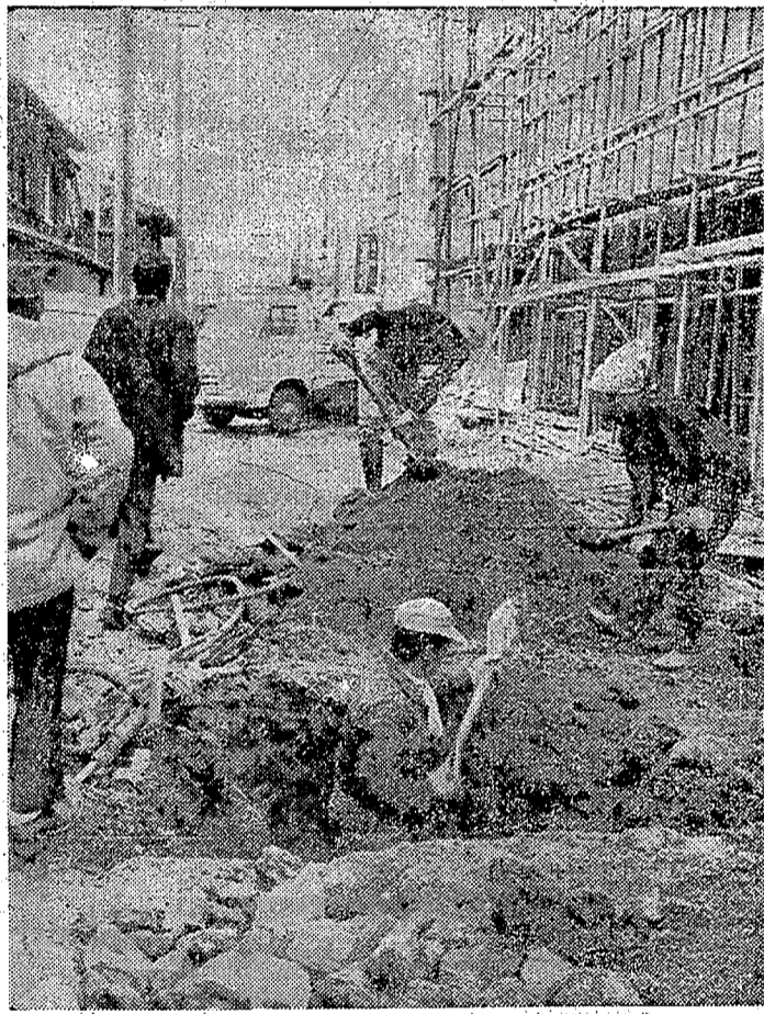
建築が進むビル前道路では、ガスと水道の埋設工事が進められている(四町目裏通り)
