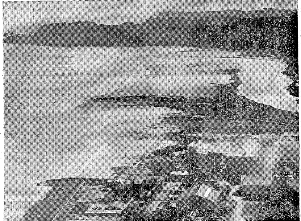
石油コンビナートの建設地帯となる富士興産株式会社の原油貯蔵タンクと製油所。大別地区臨海工業地帯に建設される。
