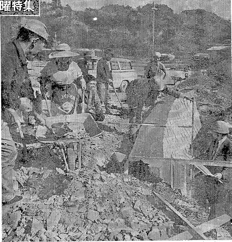
市の道路改修工事現場では手抜き箇所がなく、規格とおりの工事が行なわれているが臨時の遊歩道も設けられ、四倉町八基上岡地内で
