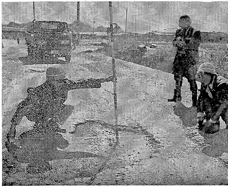
江戸前、の陸前浜街道に逆行しないよう 市道に搬入された旧6号線の間、舗装破損箇所を調査 復旧の対策をたてる(神谷岡地で)
