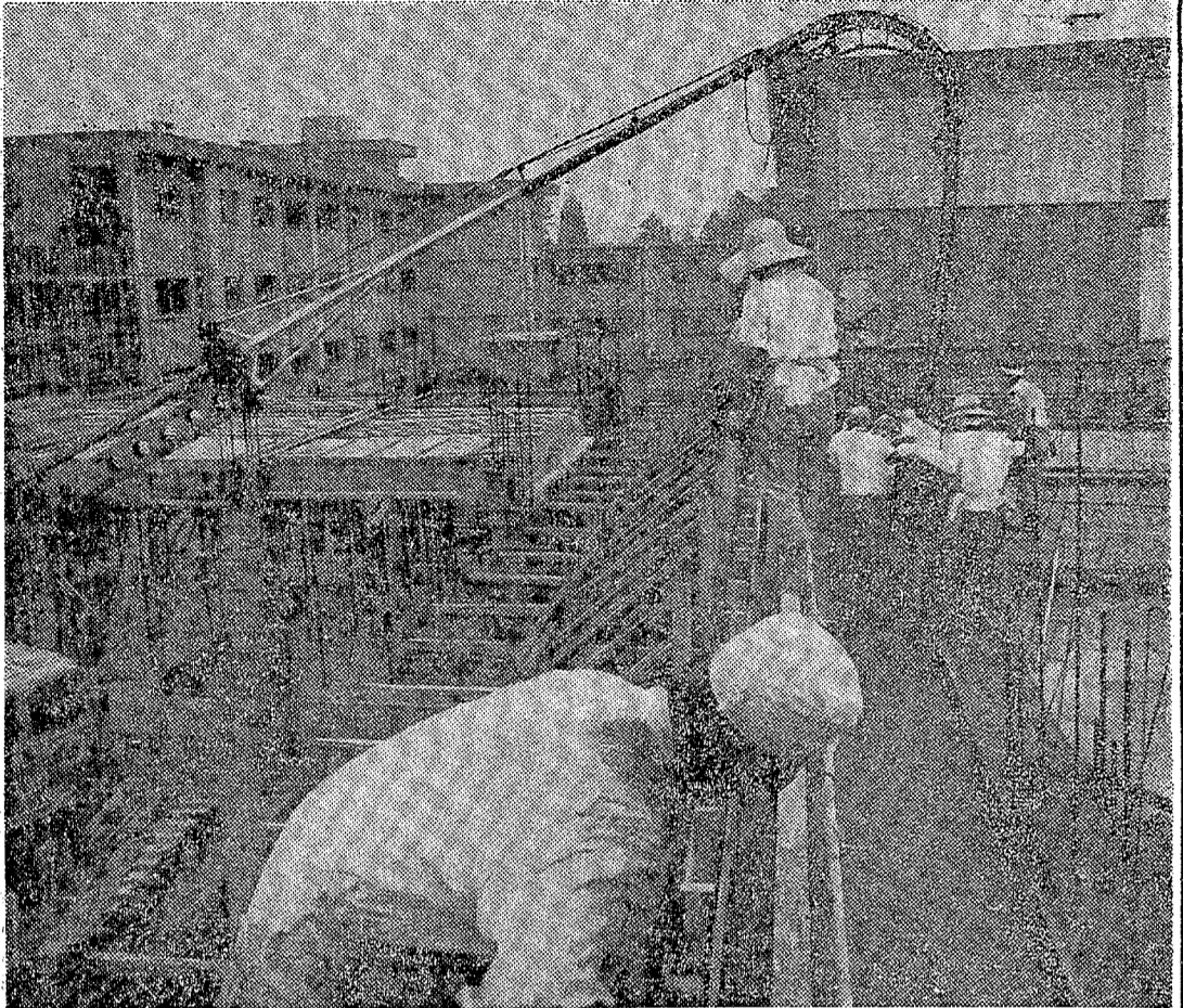
9月から授業が始まった かつわらでは第3期工事の本館と実習工場の建設が進められている 屋内体育館2棟は最終工事となる
