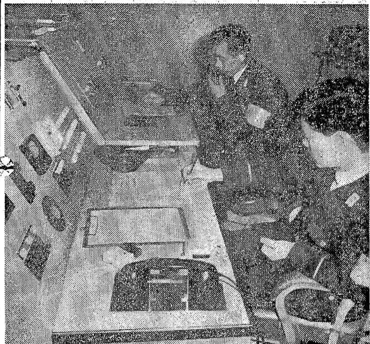
無線指令室 全いわき市内の110番はこの交換台に集中し、ここから各パトカー所轄署に指令がだされる
