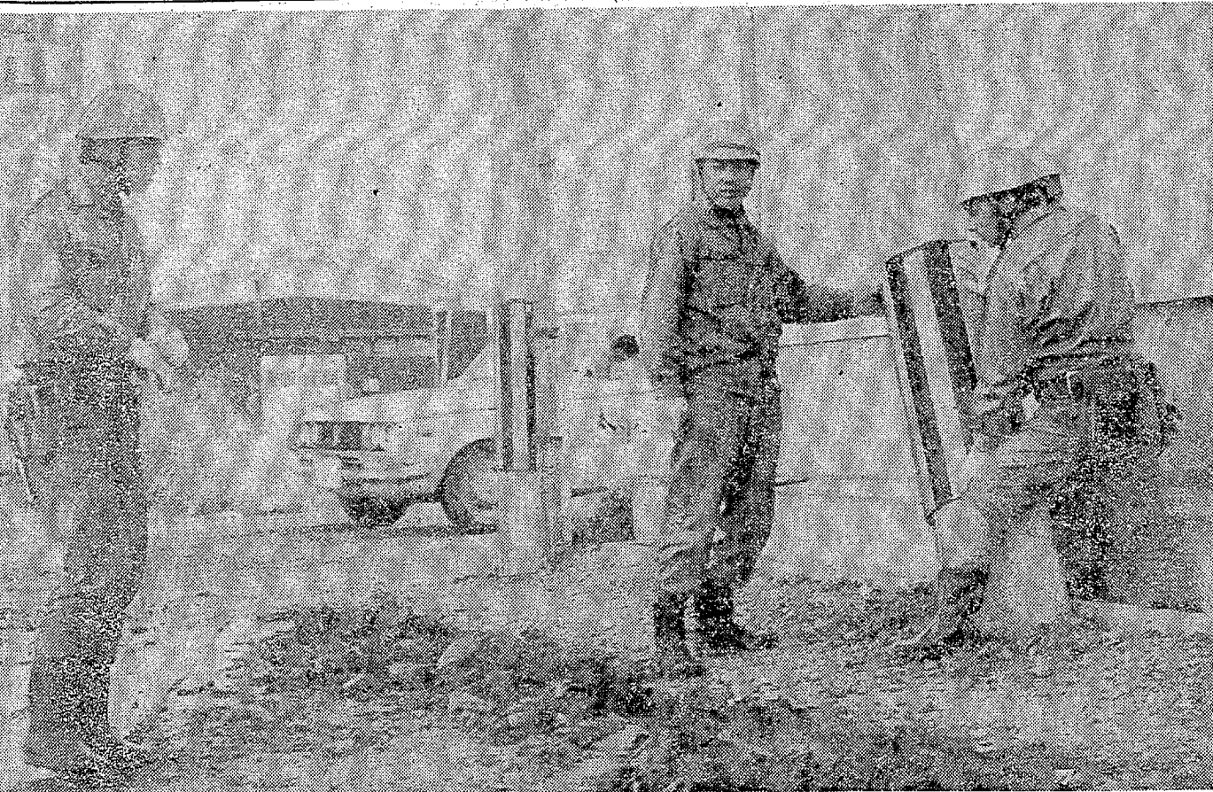
交通安全対策 サービス高揚運動の一環として、北白土方面50本の電柱に「ライト識別距離100m」の電柱標識板を取りつけ、車の激増による電柱への衝突事故防止と、電柱折損での停電を防ぐ一石二鳥の対策
