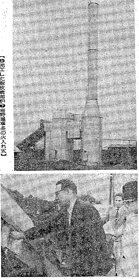
【完工した樹皮焼却炉】吉野理幸の火入れ式
