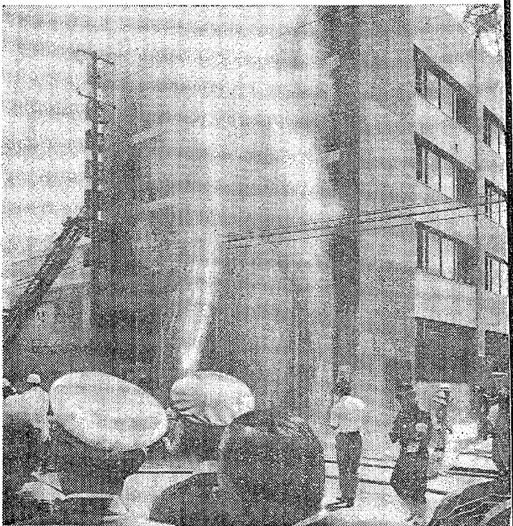
ビル火災消火 強度の地震のためシャッター故障 2階から出火延焼し 客と行員が逃げ遅れ 消火救助作業が行なわれた
