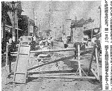
国道116号の再舗装作業が、三丁目から五丁目まで実施される。
