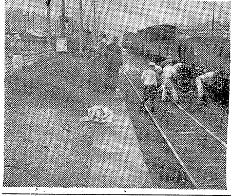
湯本駅で暴走貨車と下り列車が衝突した。乗客三名が軽傷を負った。
