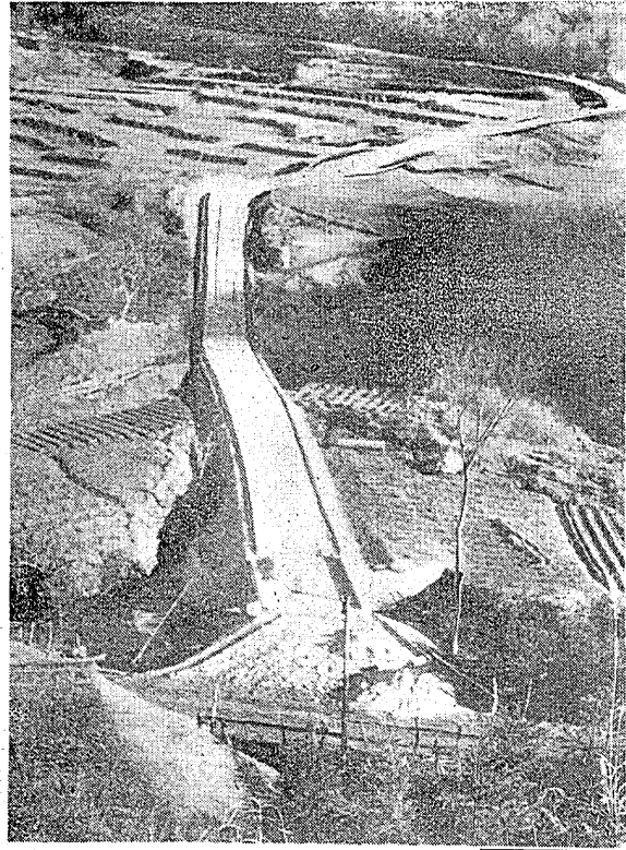
石炭採掘に水力利用の現場の様子
