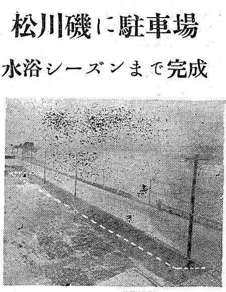
松川磯に駐車場 水浴シーズンまで完成
