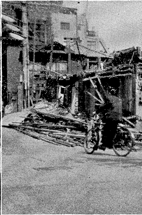
解体作業を終る平本店
