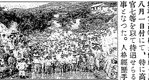
小供グループ工事奉仕従業員
