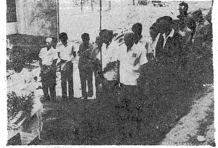
【写真】市地下道の着工式
