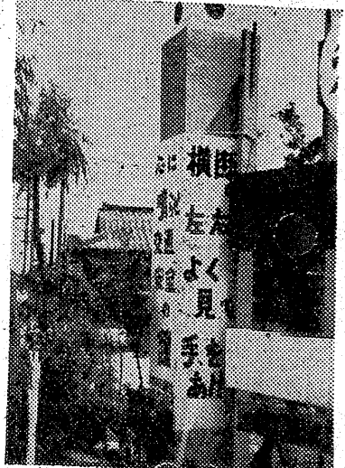
【写真】立上られた愛の塔。愛の塔。愛の塔。
