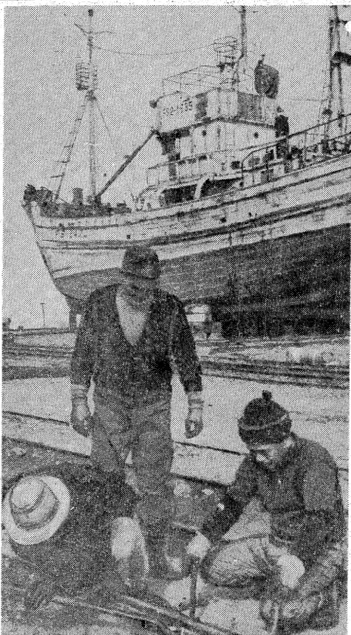
レールの取り替え作業をする作業員たち
