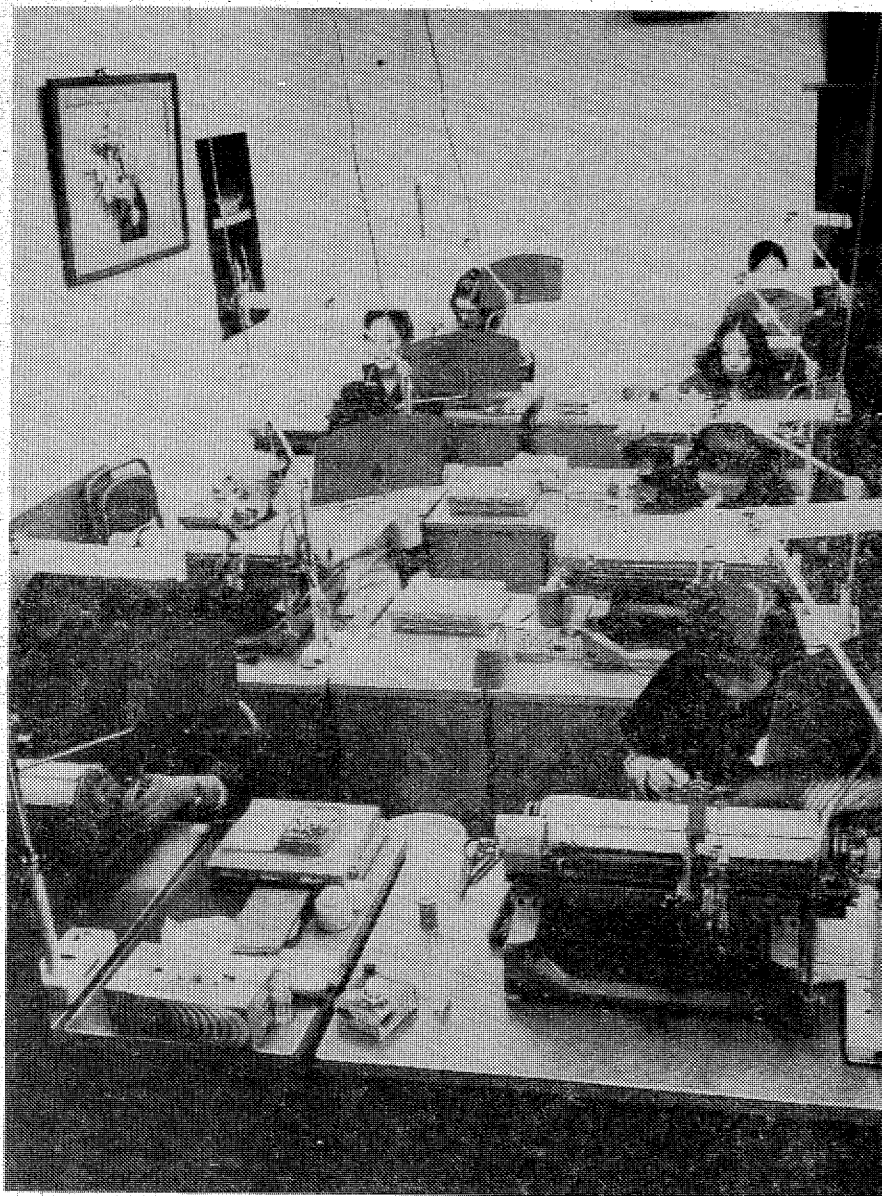
タイプレス 本文と小見出しを印字するタイプレスを8台設備 今までの文選作業が オペレーターによる印字に変わりました
