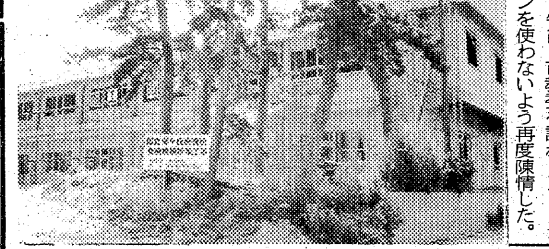
新病棟は鉄筋コンクリート造り(八百二十六平方メートル)で、療養所北側、昨年度事業で完成させた一階部分(工事内容は二階と同じ)を増築している。二、四、六人用合計十三部屋(五十床)のほか、看護婦詰まり所、診察室、食堂、浴室など八室もつくられる。総工費は八千万円。
