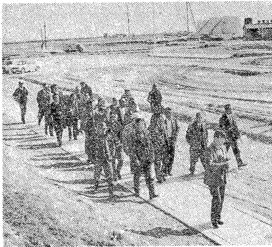
田畑市長(左)と江尻委員長(右)が視察した小名浜臨海工業団地の原油備蓄タンク群。建設を進めようとしている富士興産と地元民との関係が注目されている。
