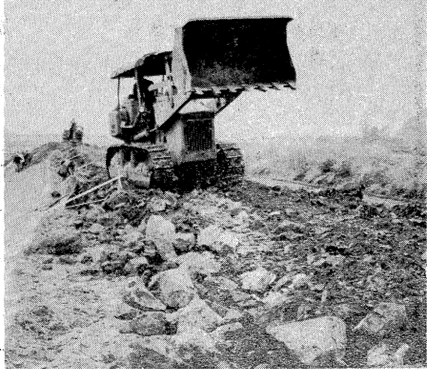
▶建設には機械力を総動員。ブルドーザ、コンボ、大型ダンプカーが大活躍。年度末ともあって作業も急ピッチ
