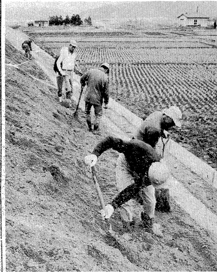
▲機械万能とはいえ、堤防の斜面整備は人が主力…シャベルや板で平面にならし、芝を植えて補強する
