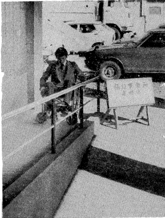
▲車イスで公共施設を利用できるようにと 市社会福祉事務所は支所、市民会館の出入り口のスロープ化を進めていたが 内郷支所など予定17施設のうち8施設の工事を終了、残りも2月に完成する
