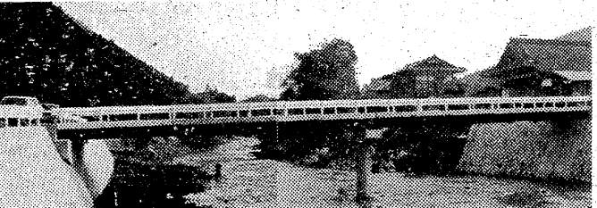
完成した渡り橋(後台橋)
