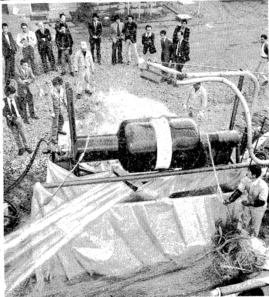
水圧を利用した投網装置、トローラー
