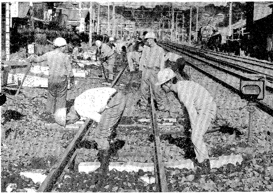
▲水鉄管理局は四十七年から八十年までの十二年計画で、水戸平区間の全線、平以北双葉までの複線化、事申区間で、枕木をコンクリート製に取り替える軌道強化工事を行っている。
