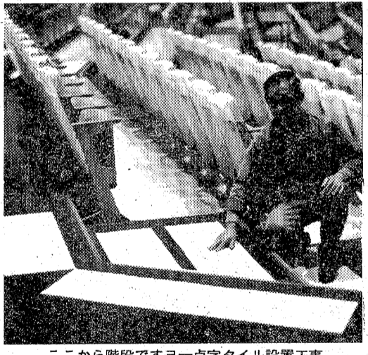
ここから階段ですヨ一点字タイル設置工事
