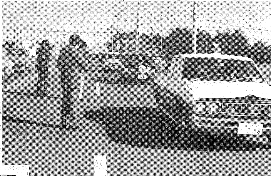
▲交通量の激増でネックになっていた6号国道・平下神谷字仲田地内〜平原高野字百目木地内(760m)の赤沼橋、原高野橋の架け替えに伴う拡幅工事が、工費3億余円を投じ磐城国道工事事務所の手で進められてきたがこのほど完成し、17日に、工事開始以来2年ぶりに開通式が行われた。
