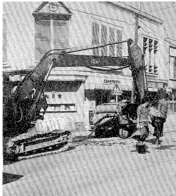
▲市常盤財産区では30日までに、新旧温泉の全面切り替えを完了する。このための第1、第2配湯所を中心に循環させる配湯幹線パイプの敷設、接続工事が急ピッチで進行している。
