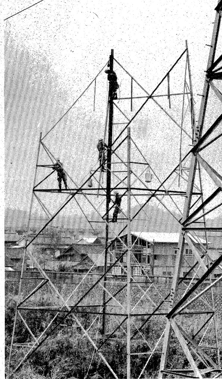
▼高圧送電用鉄塔の解体作業が、サムライスモードでの身軽な作業員たちによって進められている。常磐炭礦並火力発電所から、労災病院裏手にある内郷高野作業場にて、間の鉄塔の撤収作業だ。
