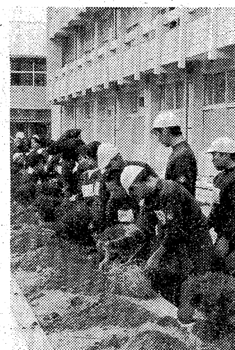
【放課後などを利用して穴を掘ったりの奉仕作業】
