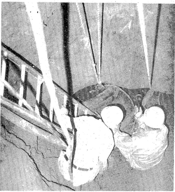
▲平赤井の赤井中体育馆で14日、ステージ前の床がフワついていたのを調べたところ、床下の土が崩れ落ちて直径約4m、深さ5mの大きな穴がボッカリ。市教委の調査では、同中付近一帯は旧日曹赤井炭鉱の坑道が八方に広がっており、ここに地下水がたまつて地盤が陥没したとみられており、19日から復旧作業が始まられた。
