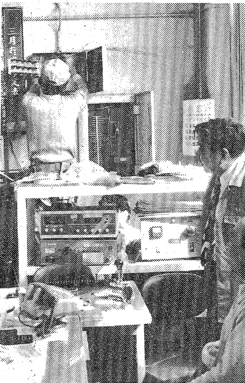
消防法によって三月中旬に非常用放送設備の新設が義務付けられているため、勿来市民会館は二十二
