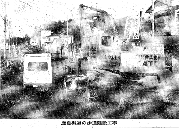
鹿島街道の歩道建設工事
