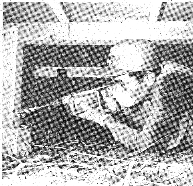
【木材に薬液を注入するために穴をあけている作業員】
